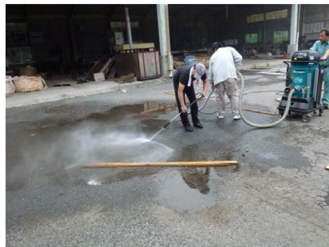
丁寧に高圧洗浄を行い、その水を吸引器で吸い取る作業
